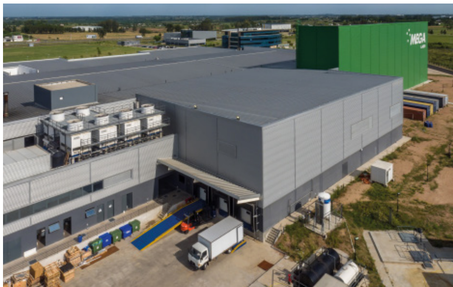
Załadunek i rozładunek odbywa się na osobnych rampach, dzięki czemu czynności te ze sobą nie kolidują
