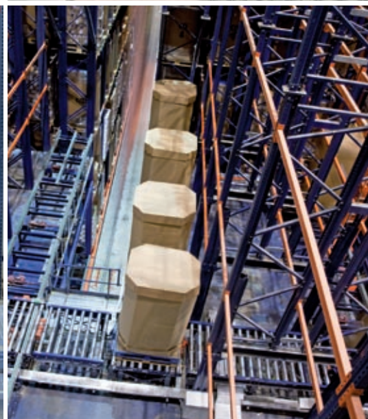
Przenośniki w korytarzu roboczym
